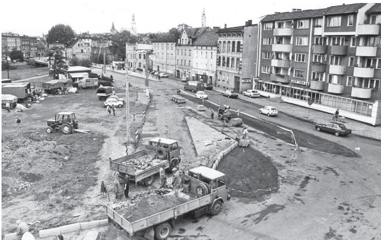
Niewątpliwy dorobek III RP to odnowa zabudowy, sieci dróg i całej infrastruktury technicznej w naszym otoczeniu. Wiele zrobiono, ale i mnóstwo rzeczy jest jeszcze do wykonania. Na fotografii budowa pierwszego prudnickiego ronda na Taborach. Wkrótce wokół niego powstało okazałe centrum handlowe miasta. Do dziś trwają dyskusje, czy lokalizacja w tym miejscu sklepów wielkopowierzchniowych była korzystna dla gospodarki miasta.
